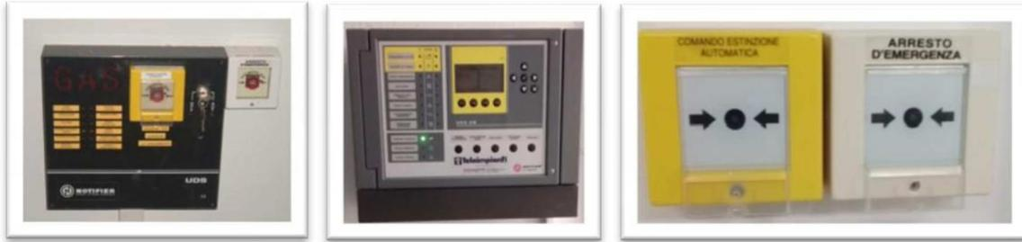
Dalle 18.00 alle 08.00 (il sabato e la domenica h24), il sistema di spegnimento funziona in modalità automatica; in questo modo la centrale di controllo, una volta ricevute le segnalazioni d'allarme di almeno due o più rivelatori incendio collocati in ambiente nel locale protetto, attiva la procedura di spegnimento; dopo circa 34 secondi, avviene la scarica del gas.
