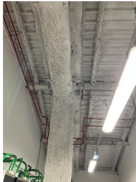
Sistema di rivelazione e sistema di spegnimento a gas del locale batterie
