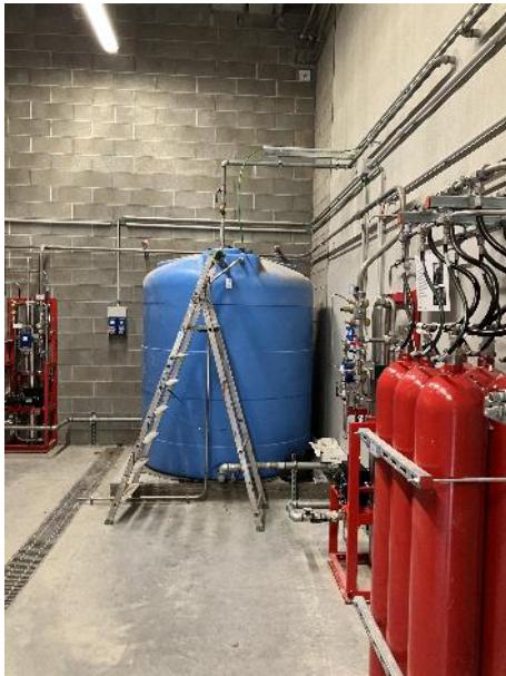
Riserva idrica antincendio (edificio G1)
