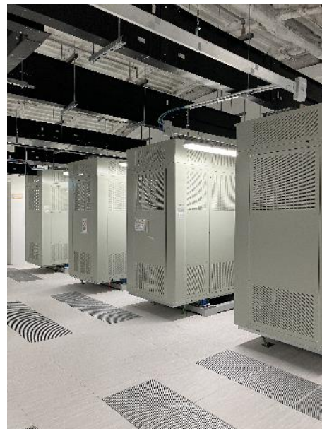
Trasformatori in resina (cabina elettrica al primo piano dell'edificio C2)
