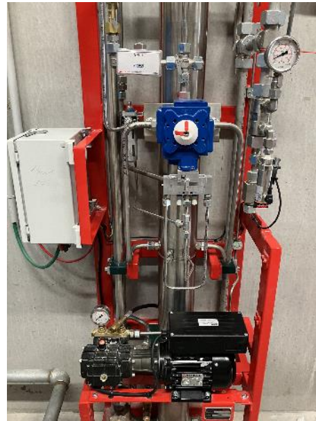
Elettropompa dell'impianto antincendio water mist (edificio G1)
