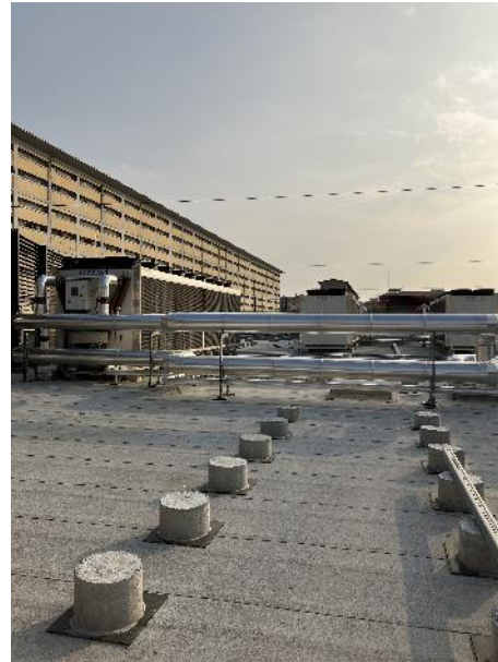
Drycooler (tetto edificio G1)
